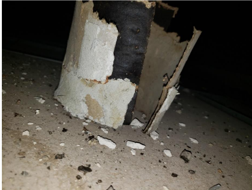
Photo. 3 – Isolant fibreux endommagé situé dans couloir C108.
