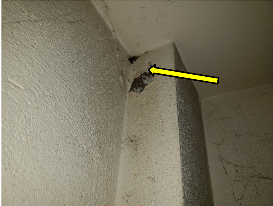
Photo. 1 - Crépis endommagé situé au mur dans l'escalier E002.
