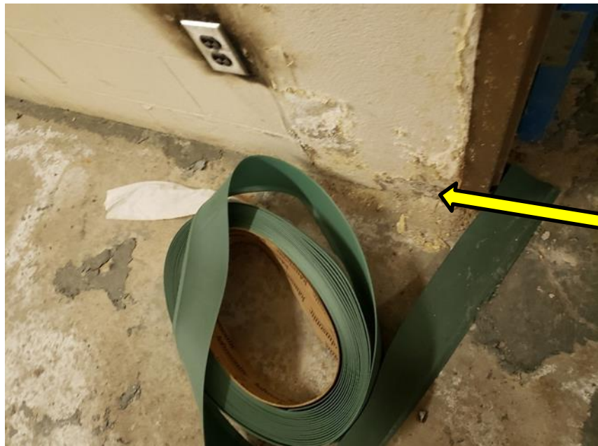
Photo. 2 – Crépis endommagé situé au mur dans couloir C001.
