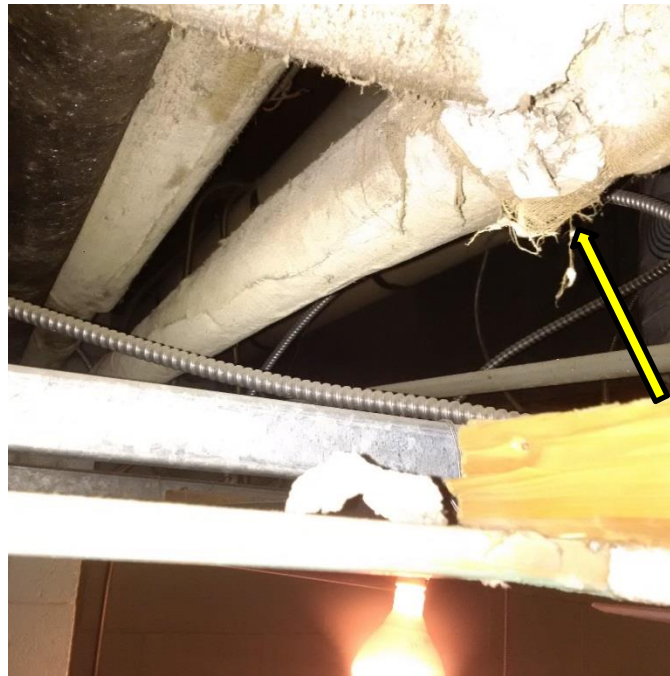
Photo. 5 – Isolant fibreux endommagé situé dans la salle 156
